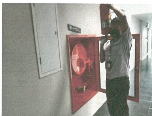
รูปภาพที่ 2.18 การตรวจสอบระบบป้องกันและแจ้งเตือนอัคคีภัย
